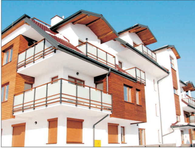
Mały dom wielorodzinny w Rzeszowie, przy ulicy Kujawskiej.
