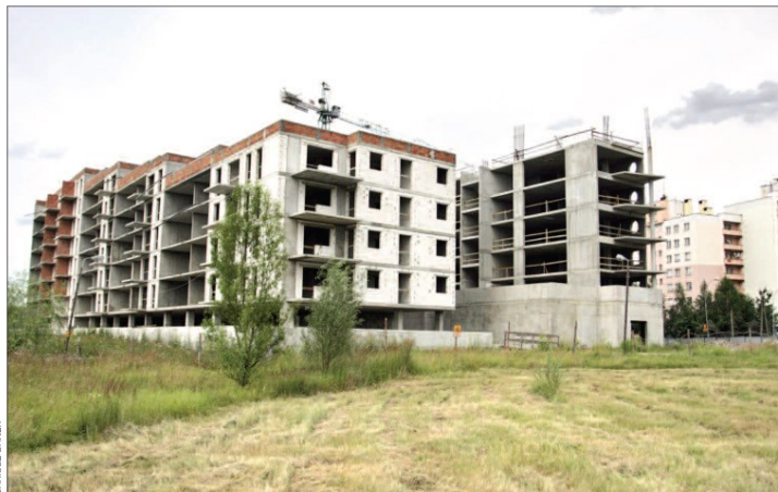
Budynek A „Apartamentów nad zalewem” jest w stanie surowym, otwartym. Przy budynku B trwają prace przy 6. kondygnacji.
